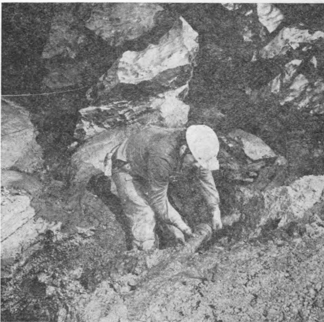
A leszivó csövek kiszerezése árvíz után (Borzásák—Prágai felvételei)
