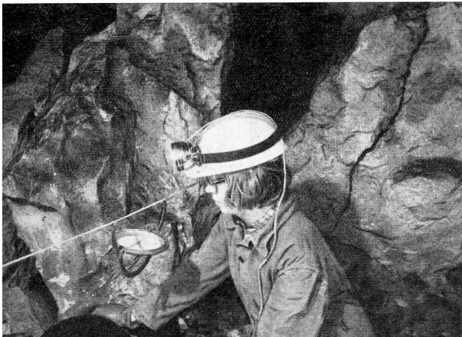
17. ábra. Függőkompass használata a barlangban. (Csekő Á. felv.)
