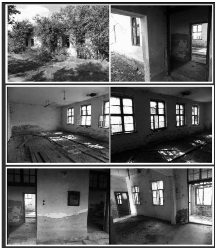
14. kép – A bogárzói iskola épülete napjainkban (forrás: saját készítésű fotók)
