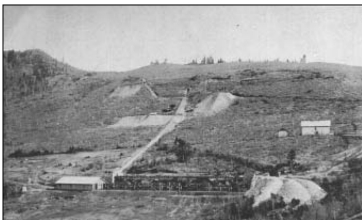
A felsőhrádeki bányák látképe. Fent: a tárolók bejáratai, középen a siklópálya, amelyen a szállítás felülről lefelé történt, lent a rakodó és a termelvényt a csetneki vasgyárba szállító kötélpálya feladóállomása.
