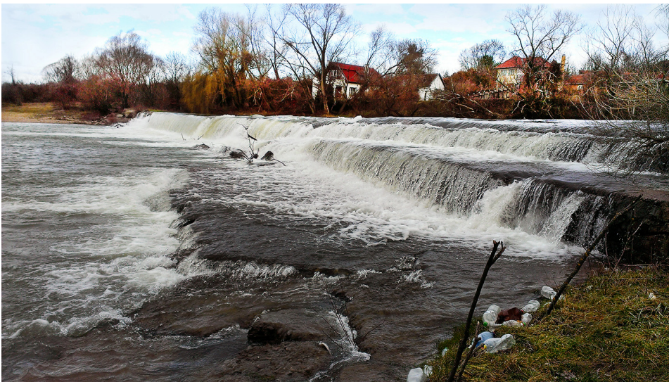
Fig. 4. Barrage area at winter in a overflow period 4. ábra. A gát környéke télen áradáskor
