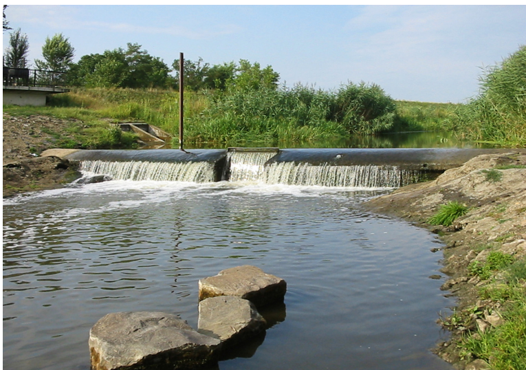
2. ábra. Fenékküszöb a Zagyva jászberényi szakaszán (68 fkm)
