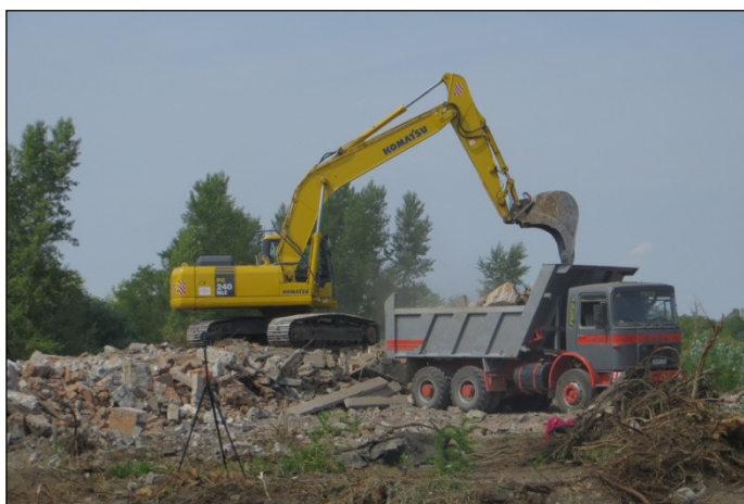
9. ábra: Az épületek és a betonozott felületek bontása
