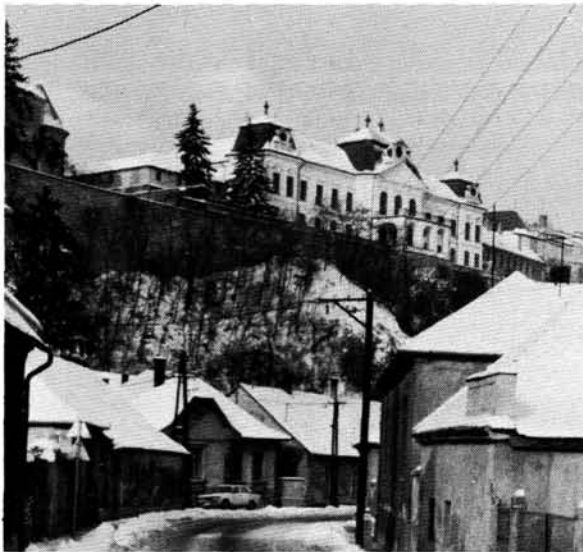
1. ábra. A püspöki palota nyugati homlokzata Abb. 1. Die westliche Fron vom bischöflichen Palast
