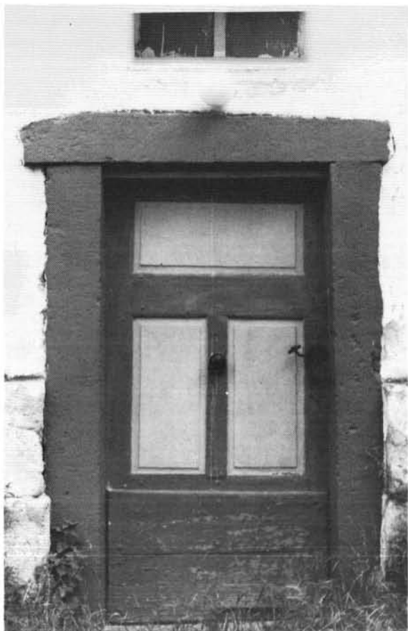
4. ábra. A templom északnyugati oldalbejárata Abb. 4. Nordwestliche Nebeneingangstür der Kirche
