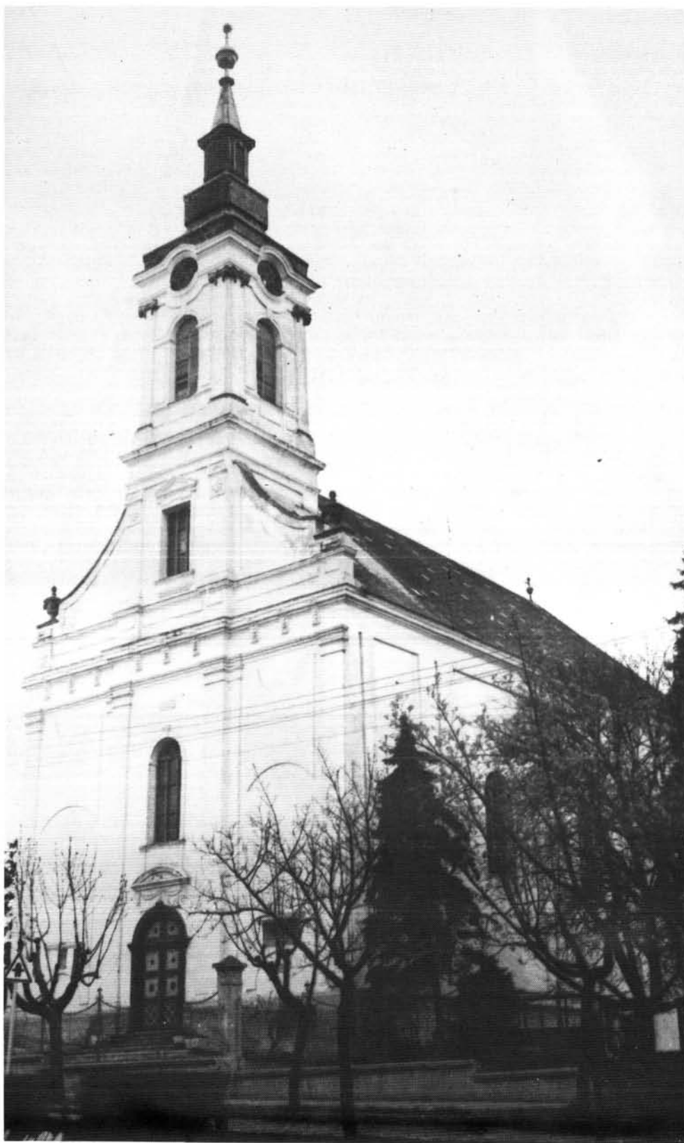
2. ábra. A balatonfüredi református templom déli homlokzata Abb. 2. Die südliche Fassade der reformierten Kirche von Balatonfüred
