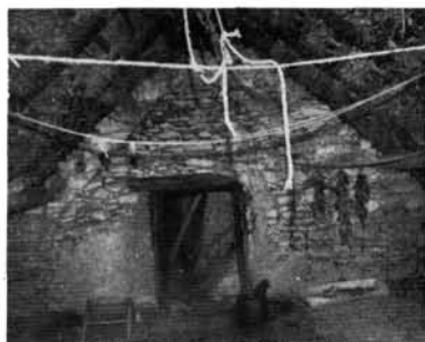
13. ábra. Szelement tartó, ajtóval ellátott középső oromfal (csipkefal), Mindszentkál, Rákóczi tér 18.
