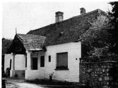
13. ábra. Szelement tartó, ajtóval ellátott középső oromfal (csipkefal), Mindszentkál, Rákóczi tér 18.
