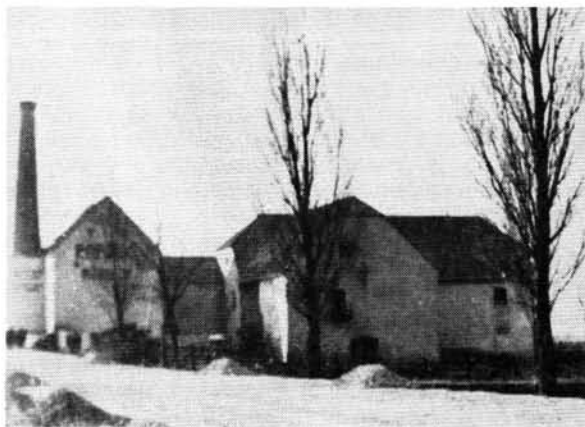
5. ábra. Az igali „Papiros Múmalom” épületegyüttese Dél felől. Nádasy Lajos felvétele 1945 előtről Abb. 5. Gebäudeensemble der „Papiermühle” von Igal, von Süden gesehen. Aufnahme von Lajos Nádasy von vor 1945
