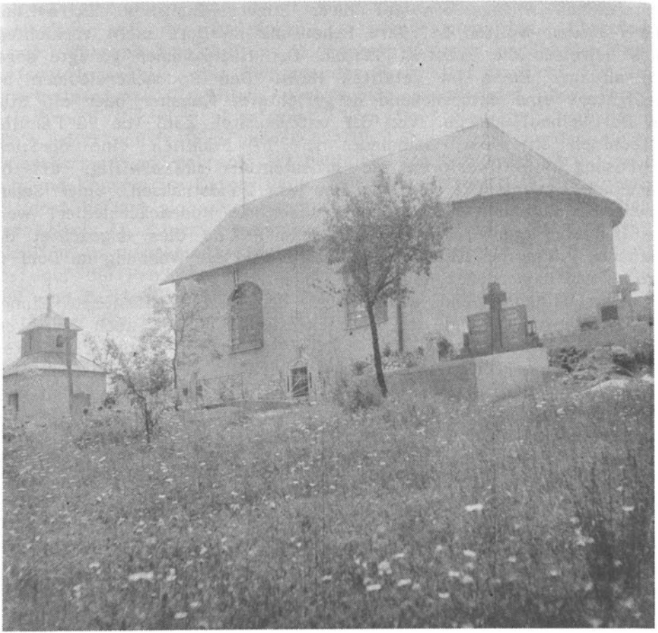
Abb. 3. Kirche samt Friedhof in einer Rodeackersiedlung. Hont.
