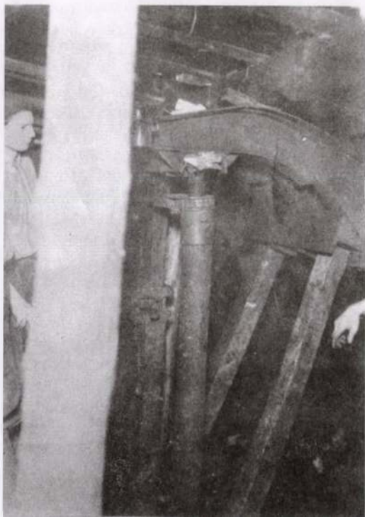
2. kép Páncélpajzsos frontfejtés (kísérlet 1953-ban)
