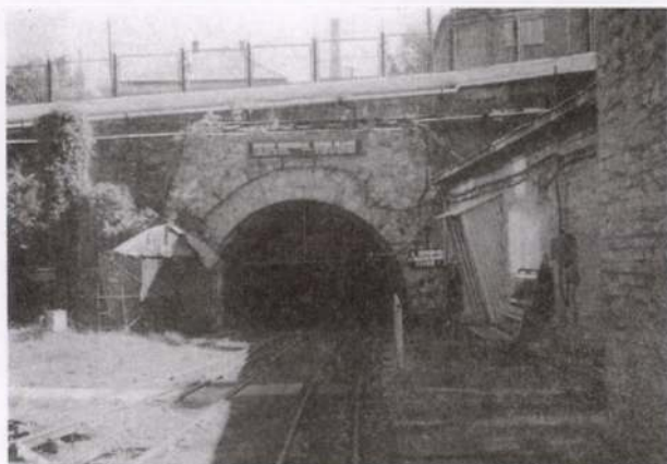
1. kép Komlói altáró bejárata (2000. augusztus)
