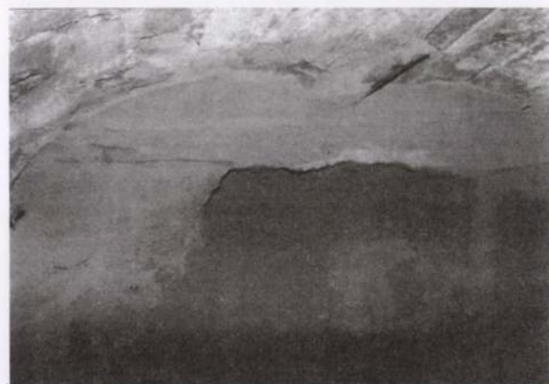
3. kép Próbaszakasz tömedékelése és a gátelbontás utáni állapot
