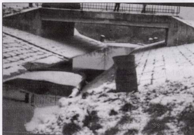
4. ábra. Az ún. Zámolyi-híd
