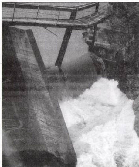
1. ábra. A recski ércbánya víztározójánál 1999. júliusában megroppant zsilib
