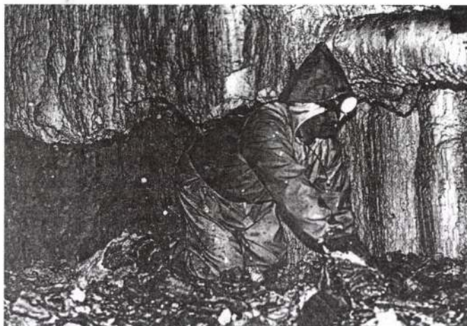
7. ábra. A vízkővel borított járóosztály a -691 m Bf. szinten az aknában
