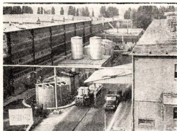
1. ábra. A Székesfehérvári Könnyűfémű központi emulzióbontó állomása
