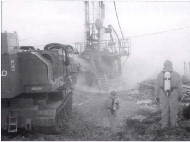
3. kép. Ikerturbó-berendezéssel olvasztják a jeget
