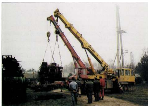
3. kép. Az FR-4 típusú Trauzl-berendezés emelőművének lerakása
