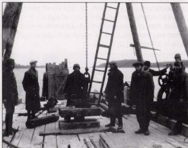
5. kép. Próbafúrás a Duna-mederben pontonhidról, a Medve híd helyén
