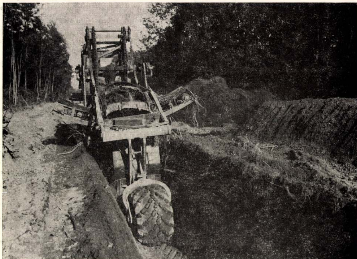
Távvezeték-építés — ároknyitás (Kőolajvezeték Építő Vállalat)
