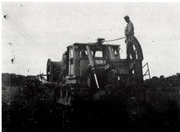
1. kép Hírközlő és telemechanikai kábel fektetése a csővezetékkel párhuzamosan
