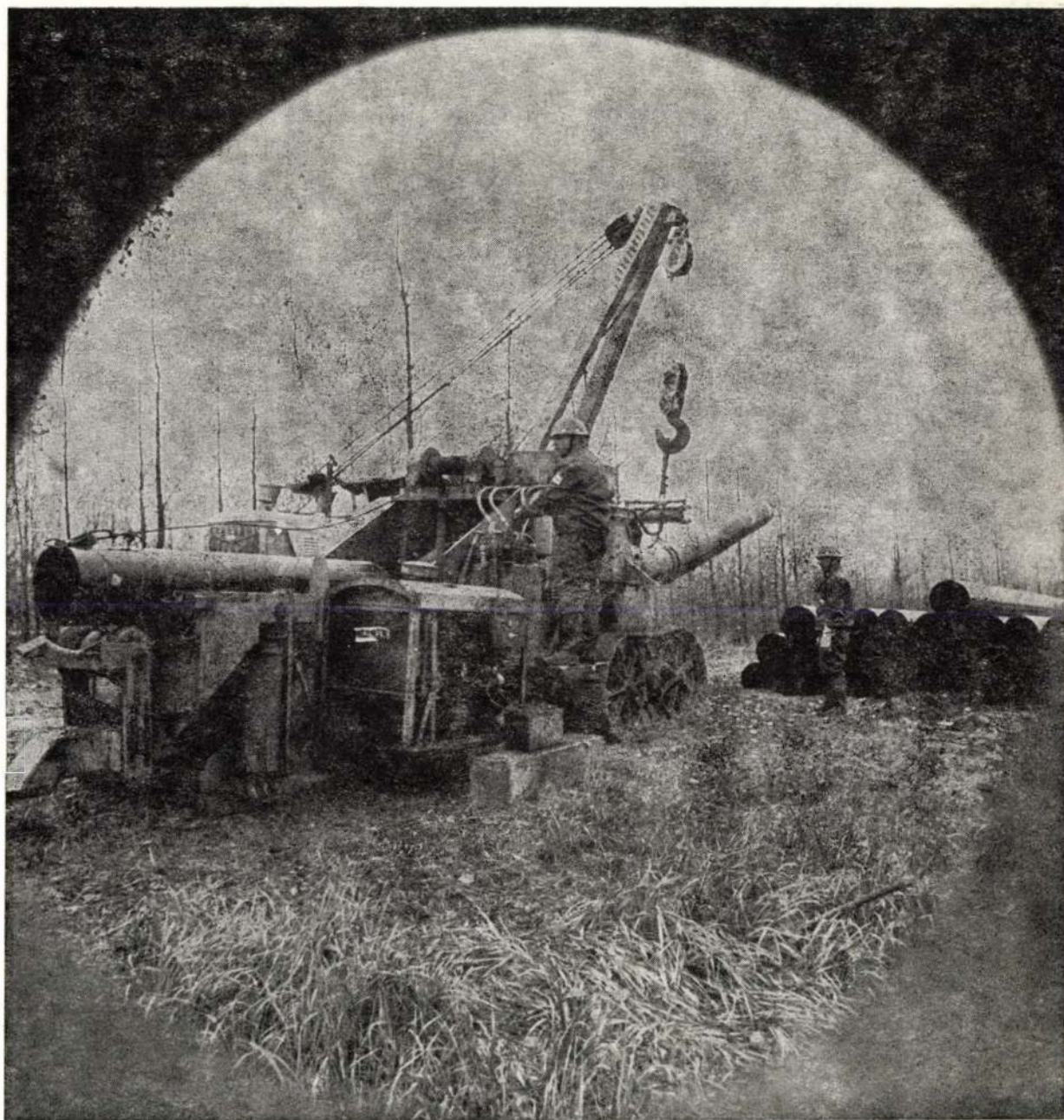
Vezetéképítés a Kőolajvezeték Építő Vállalatnál
