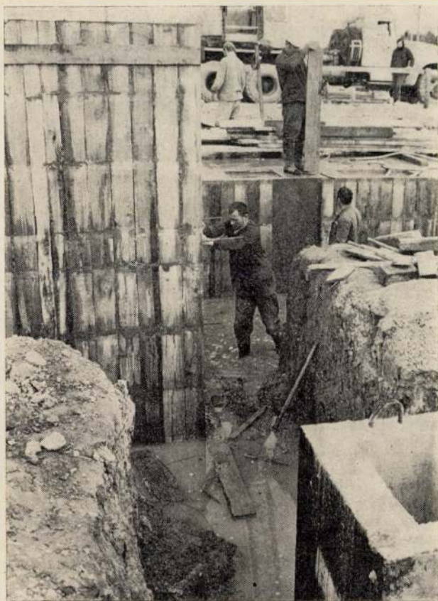
Zsalubontás a turbina és kompresszor gépalapjainál
