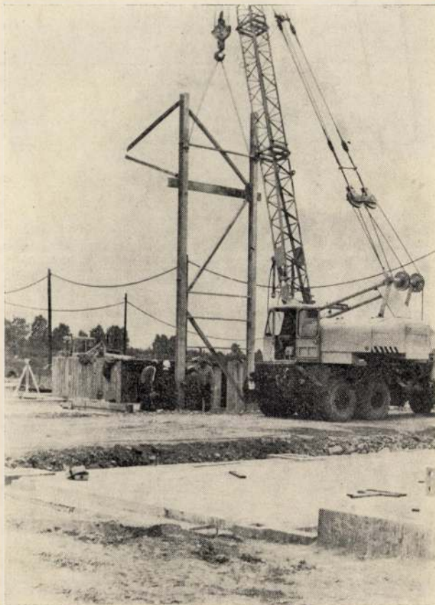
A kompresszorház vázának szerelése
