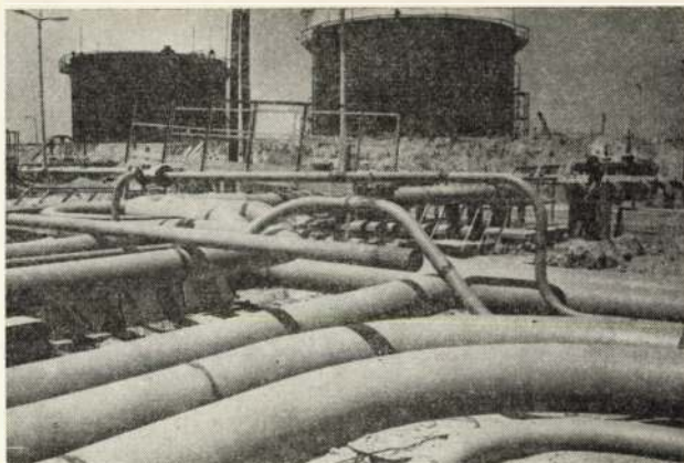
5. ábra Az elosztóhálózat csövesordája építés közben (székesfehérvári ÁFOR-telep)
