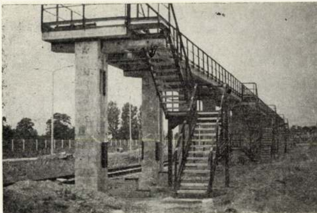
3. ábra A PB vasúti lefejtésére szolgáló híd (Horti, PB-telep)
