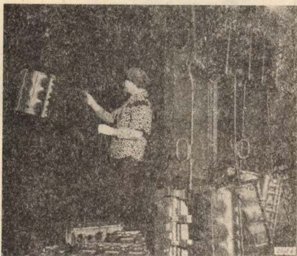
6. ábra. A kis sorozatú öntvények festése a Valmet OY Rautpolju öntőben
