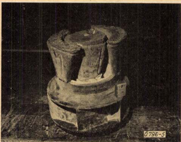
5. ábra. A nyers öntvény a felöntésekkel
