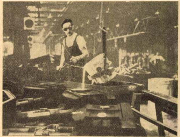
8. ábra. Az Eaton-Erb. eljárás szerinti vasöntés kokillába a Qualcast Limited, Derby (Anglia) öntödében. A gép egy forgó típusú több munkahelyű egység
