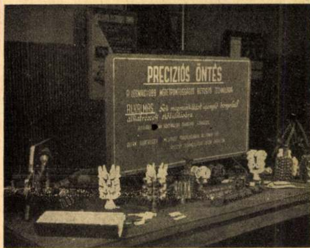
9. ábra. Precíziós öntéssel előállított alkatrészek és viaszminták a kiállítás egyik részében
