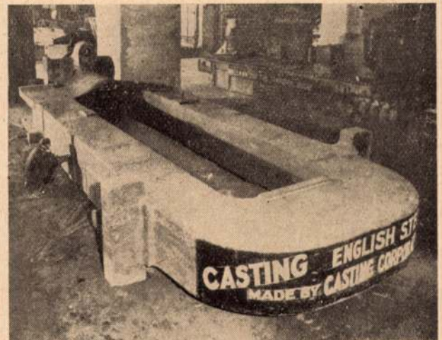
11. ábra. 164 t súlyú acélöntésű hengerállvány, mely az English Steel Castings Corp. Sheffield-i öntődjében készült. Méretek: kb. 9,9×4×2 m. Az öntéshez 205 t folyékony acél volt szükséges. A tápfejeknek folyékony állapotban való tartásához az exotermikus anyag használatát megelőzően 40 órán át villamos ívvel hevítést alkalmaztak
