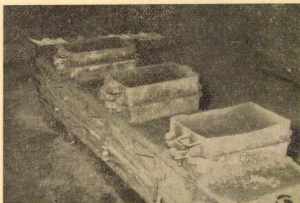
10. ábra. Leöntött forma beöntő medencékkel (rekuperátor cső)
