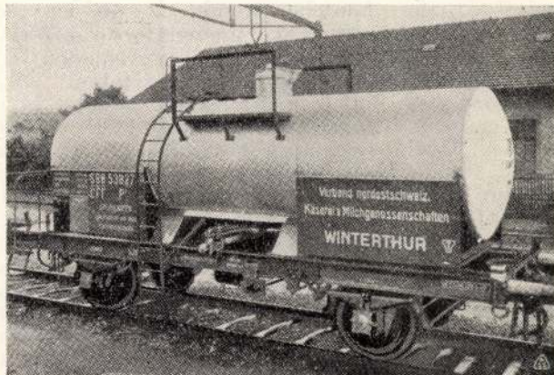
1. sz. ábra. Al-Mn ötvözetből készült vasúti tartálykocsi tejszállításra 20.000 liter befogadóképességgel.
