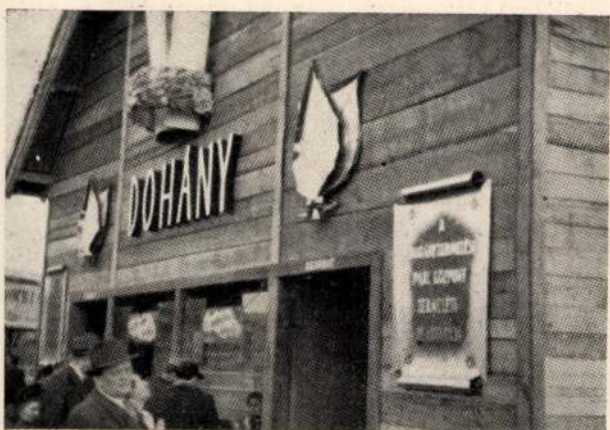
2. A Dohányjövedék pavillon homlokzatának aluminium díszítései.
