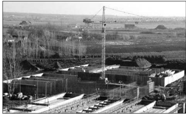
2. ábra. Épül az új eleveniszapos medence
