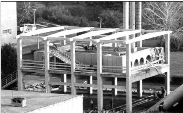
1. ábra. Az épülő finomrács
