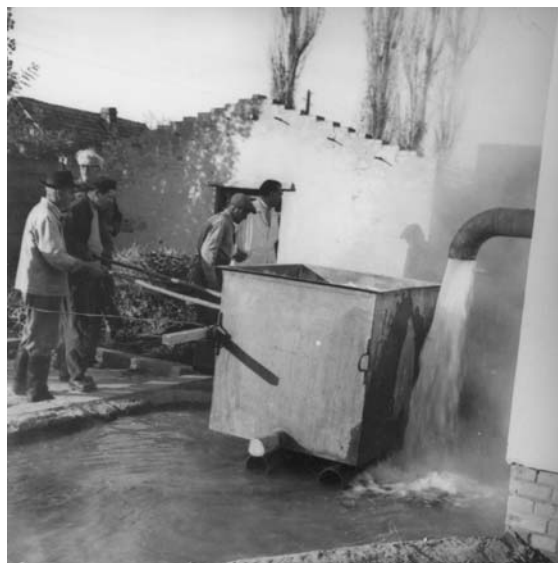
1. kép. A hévízhozam mérése 1963-ban (Szerző felv.)
