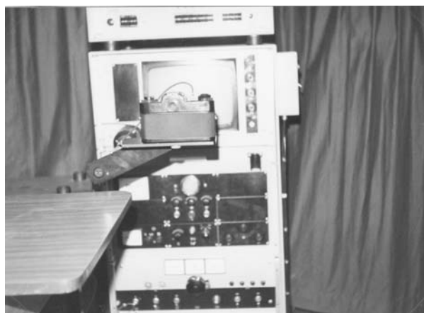
3. kép. IBAK rendszerű televíziós berendezés műszerfülkéje, digitális kijelző monitorral és erősítő berendezéssel, fényképezőgéppel
