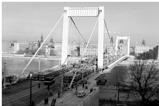
4. Az új Erzsébet-híd próbaterhelése (1964. november)
