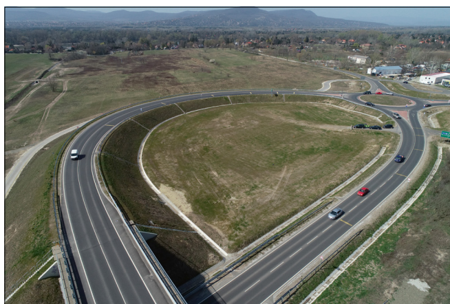
3. ábra. Légi fotogrammetriával felmért útszakasz
