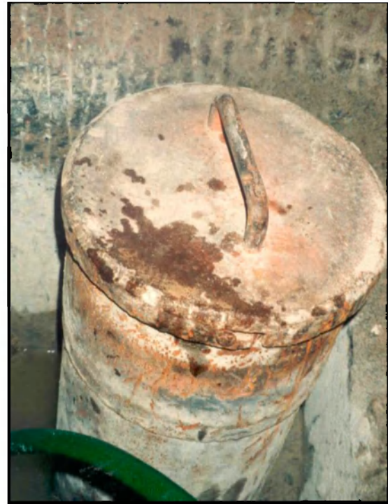
6. sz. ábra A robbanóanyag betöltésére szolgáló fémcső elhelyezkedése a robbatókamrában
