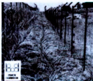
9.sz. ábra Egy és kétsoros drótkerítés dróthengerrel kombinálva
