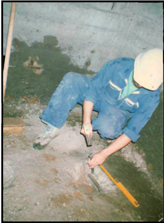
5. sz. ábra A robbatókamrák felső észének feltárása
