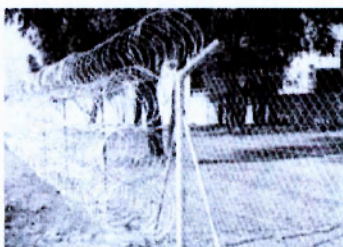
6.sz. ábra Drótkerítés fonott dróthálóból
