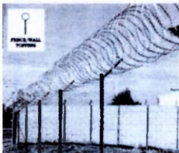
9.sz. ábra Egy és kétsoros drótkerítés dróthengerrel kombinálva
