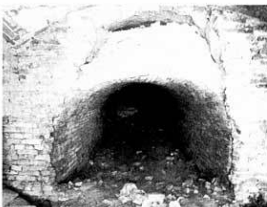
6. fotó Mindszentgodisán (Baranya m.) a felszínről jutott nagyobb mennyiségű csapadékvíz a föté fölé
