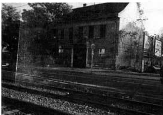
4. fotó Az iskolaépület bontásának pillanatai (fotó: Óvári Tamás)
