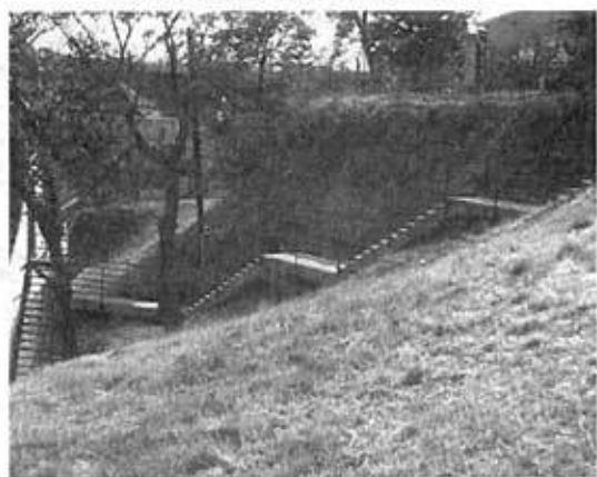
8. kép. Hun u. földtámfal a vasbeton lépcsővel
