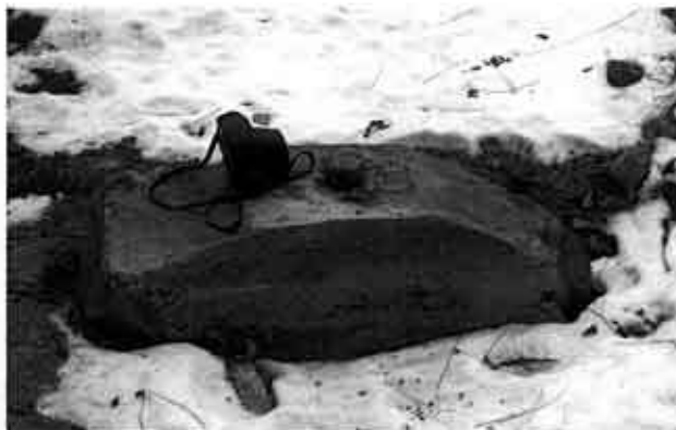
Fotó 4. Az Rm-52 számú fúrás lebetonozott (gáz által átlukasztott) szája
