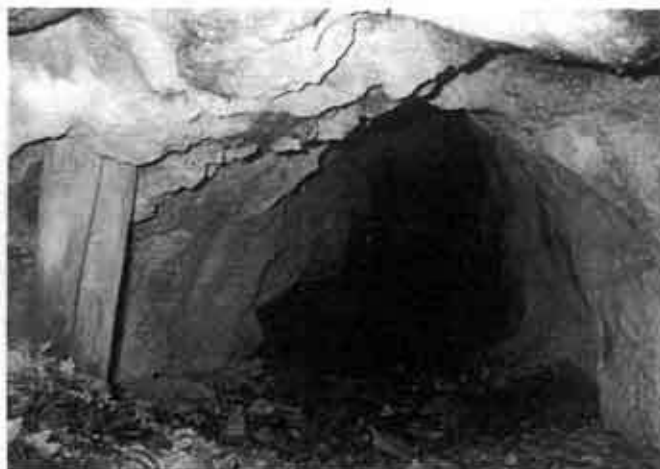
Fotó 3. A Pál - táró bejárata nyitott, a vágat hosszan járható, a savas víz (pH 2) 0,2 - 1,4 m magasan áll
