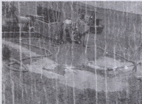
A 2. sz. ábrán láthatunk egy ülepitő gödörként szereplő tartályt a csatornát helyettesítő béléscső nyílásával.
