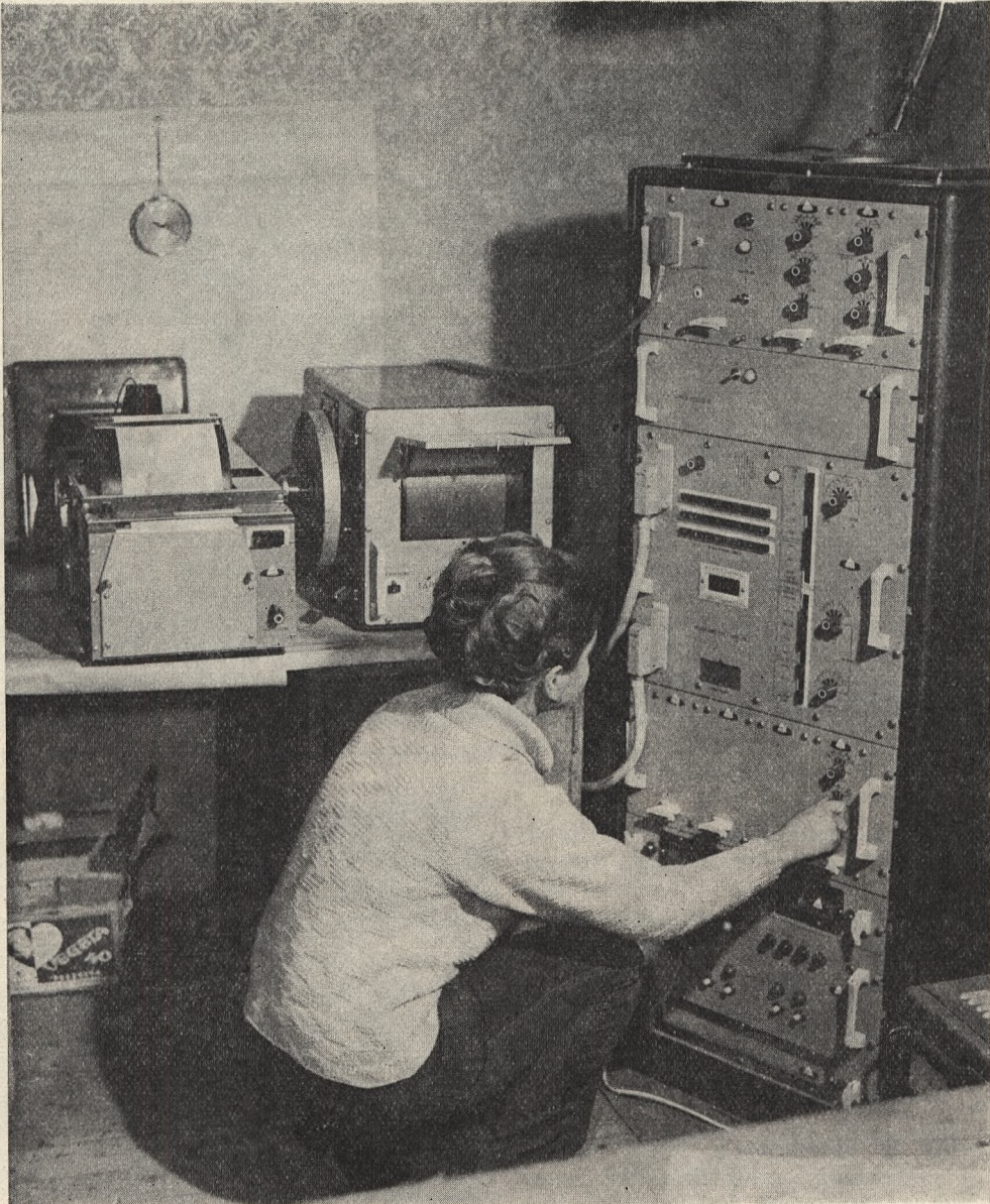
1/d ábra: Laboratóriumi visszajátszó berendezés (SzMV 24 + 6)
