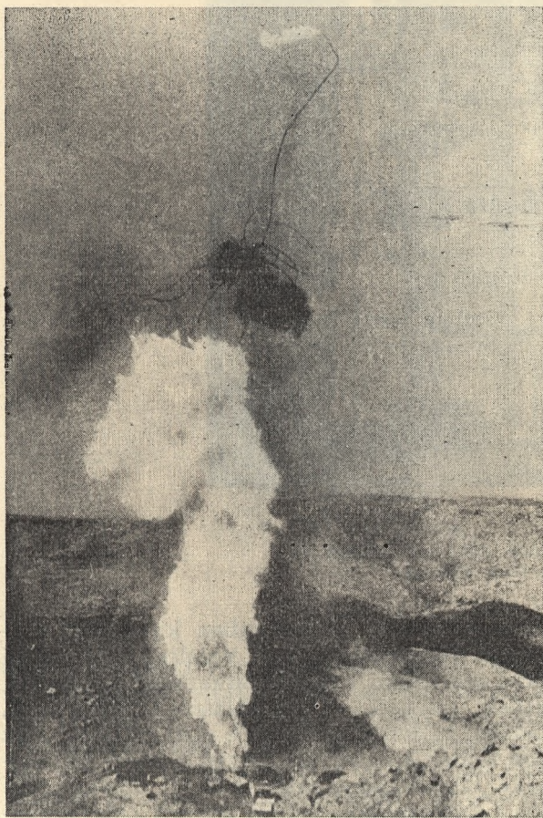
3/a) Az iráni Naft-Safid kitörést követő tűz alkalmával a kút 800 m fúrócsövet 600 m magasba röpitett ki a fúrólyukból, miközben a „csökigyó” végén még mindig ég a gáz (British Petroleum Ltd. hozzájárulásával)
