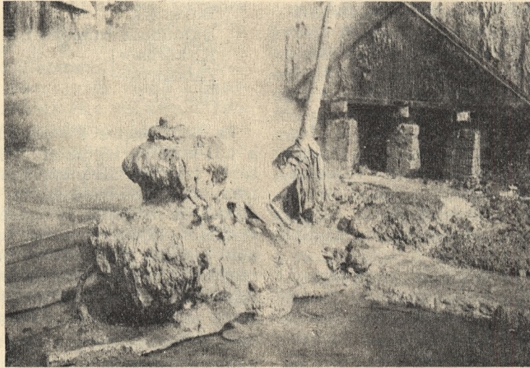
4. kép. Sólakódás a turai kút felső részén (kará-csonyfa)
