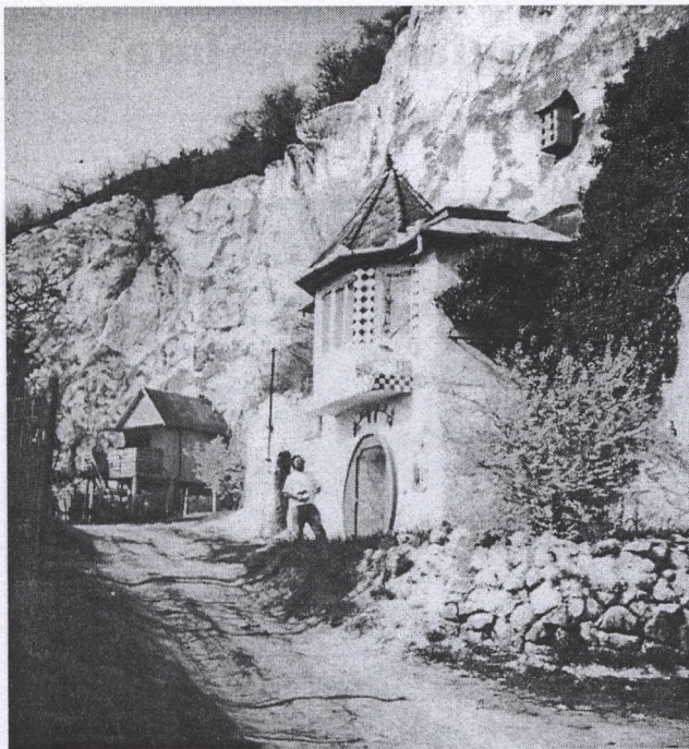
5. Szakadó riolittufa fal - Eger, Wind Téglagyár mögött
