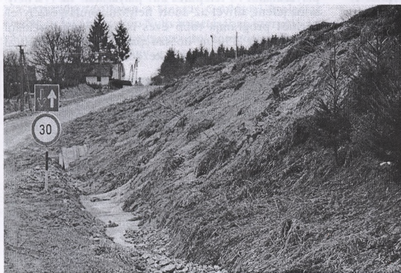
A csúszás alsó részén kilépő vizek sárfolyást okoznak - Nemespátró
