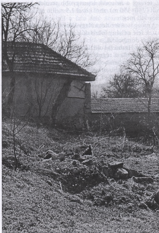
4. fotó. Dózsa Gy. u., nyírási zónában álló ház károsodása
