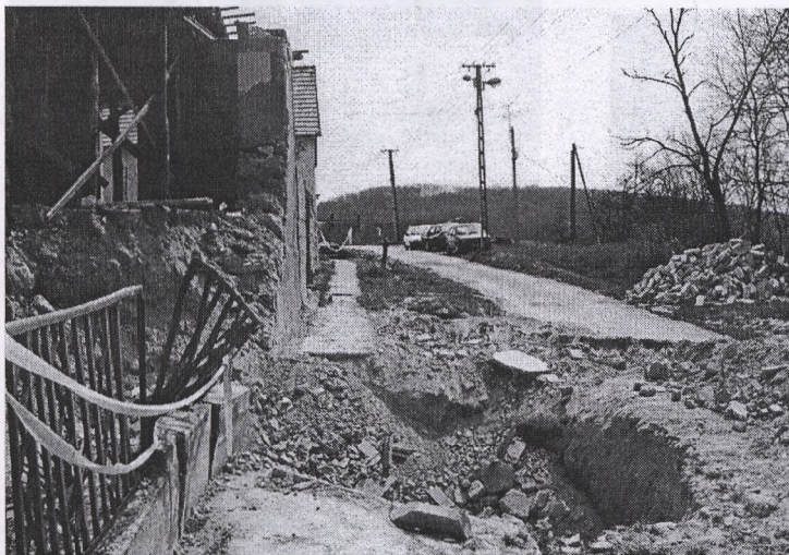
Helytelen településrendezés következtében keletkezett épület károk - Alsónána
