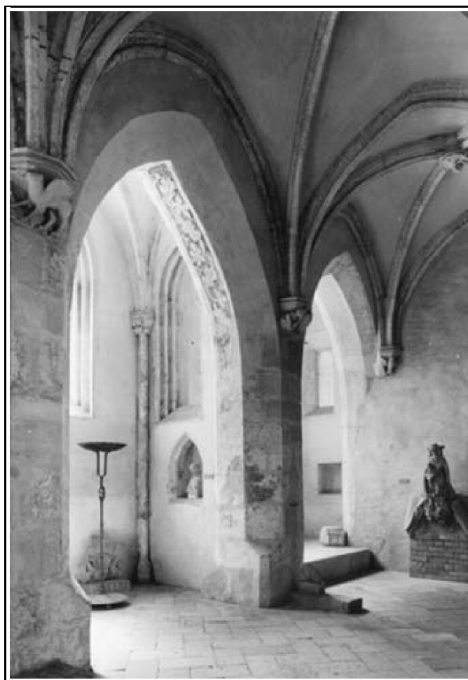
Sopron, egykori ferences kolostor káptalanterme (un. Moritz-kápolna), amelynek kiszabadítása és visszaállítása nagy szakértelmet kívánt. Helyreállítás utáni kép (1949-50).
