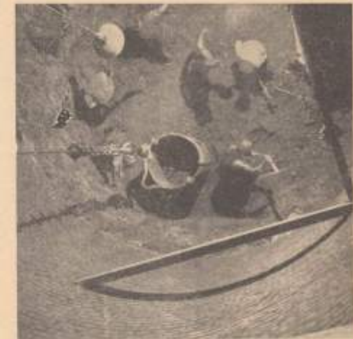
12. Az akna talpának továbbmélyítése kevésbé megfagyott talajban egy mélyítési szakasz kifalazása után.
