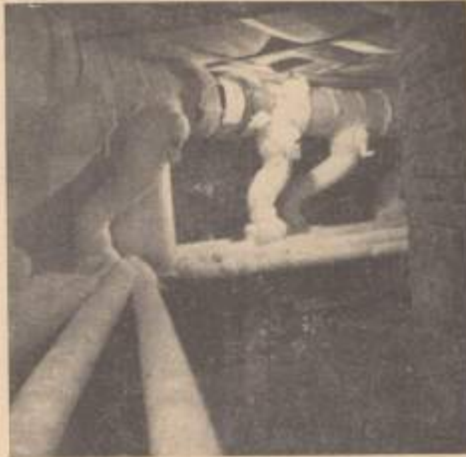
11. Az akna falán elhelyezett fagyasztópince az osztó légvezetékkel.
