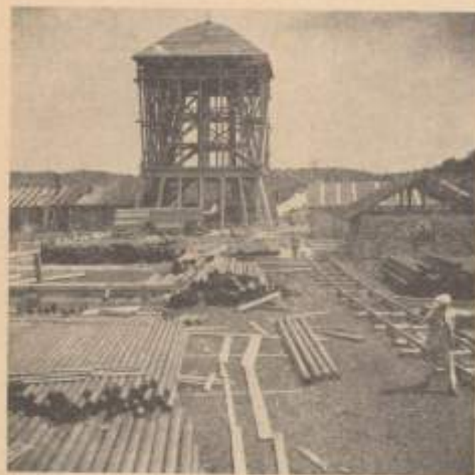
7. A fűtőmélyítő torony szerelés közben.
