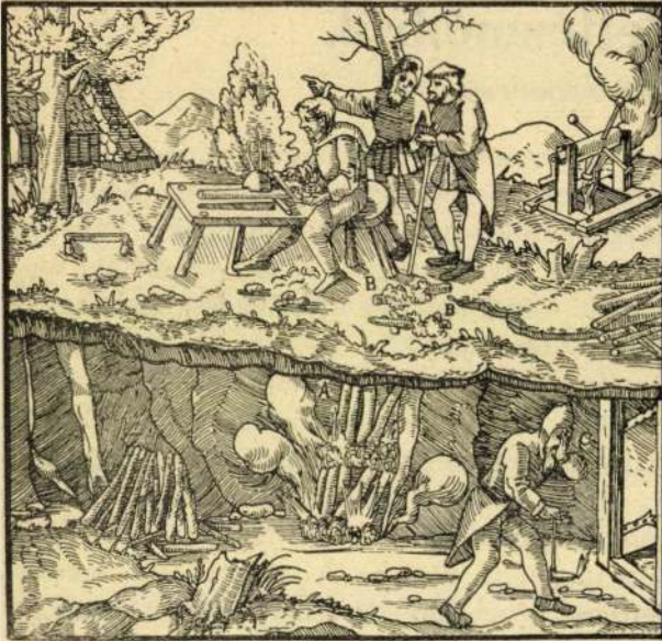
1. sz. rajz. Tüzzel való fejtésmód Agricola szerint. (L. De re metallica című munkáját V. könyv p. 84.)
