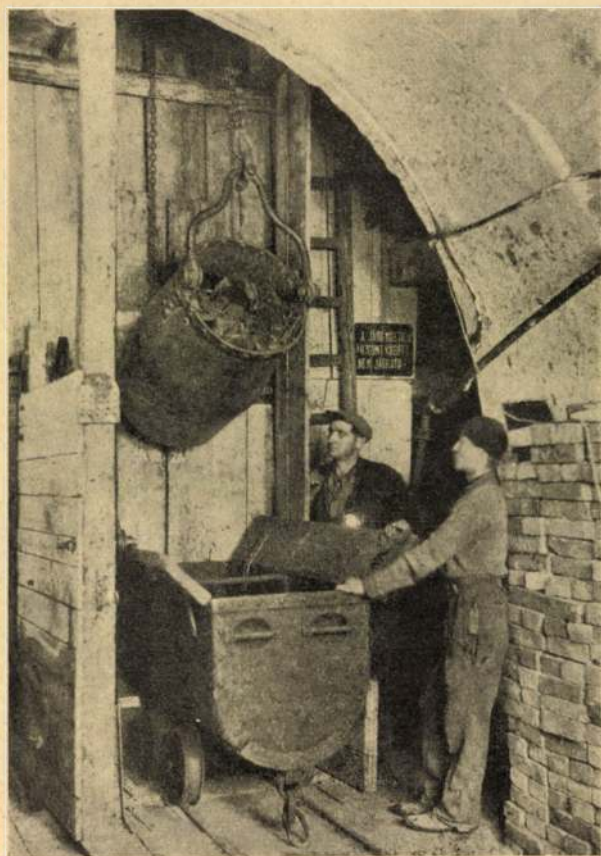
4. kép. A felhúzott szállítóödön kiürítése. (I. szintű rakodón.)
