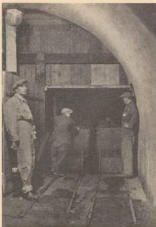
3. kép. Aknaszállítás (esillibetolás) az I. szinten, az aknaútánvét munka közben, a rakodón az aknaácsolatok beborításának szemléltetése.
