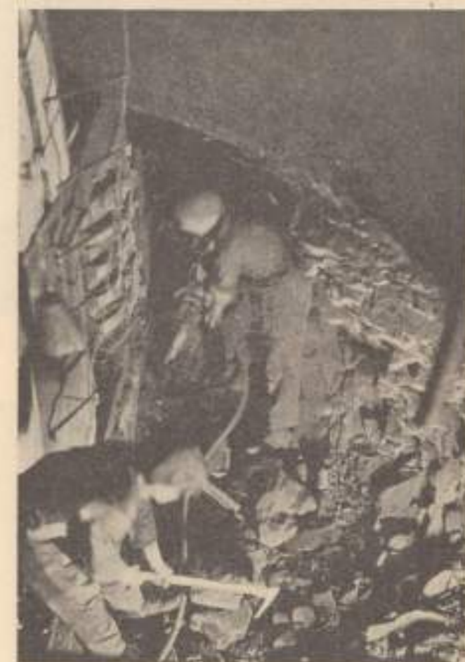
1. kép. Aknaútánvét (kitörés) az I. szint alatt. Fejtőkala-póccsal való kőzetreszelés és esákannyal való kőzetfejtés.
