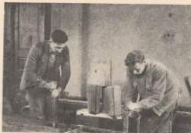
1. ábra. Az idomkövek döngölése.
