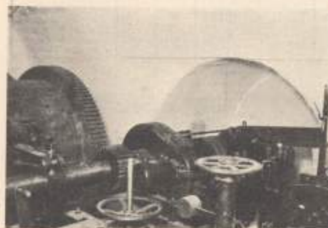
2. ábra. Géptér, a gép szerelése közben.
