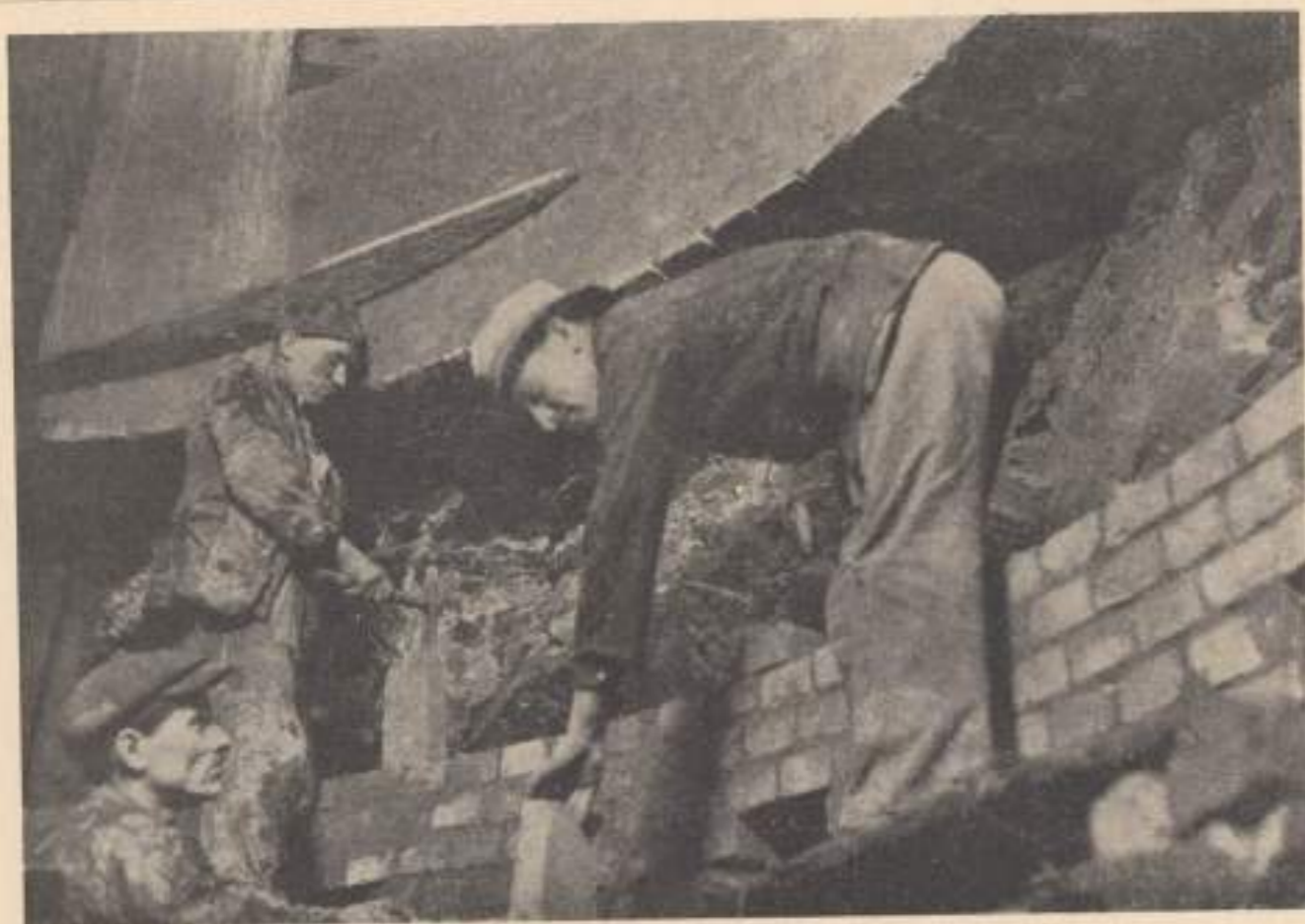
2. kép. Egy utánvét szakasz kifo lazása az I. szint alatt a 33. m-ben.
