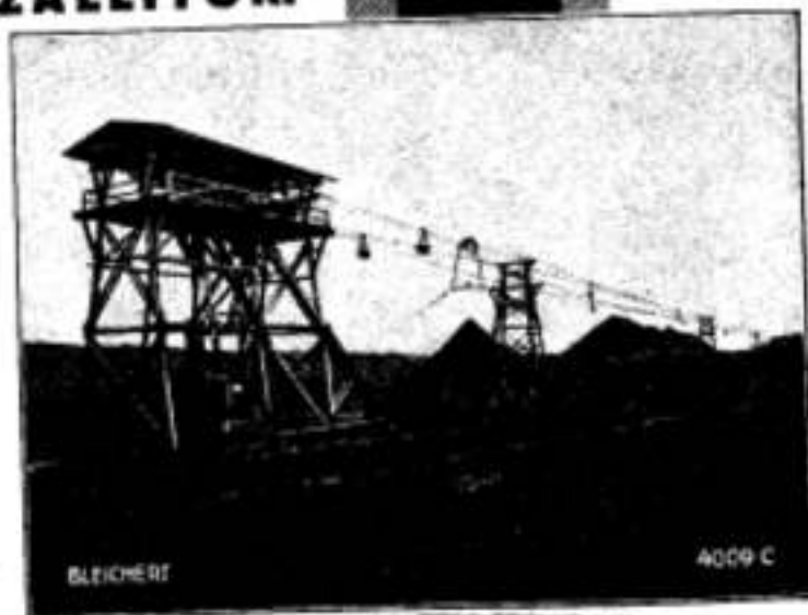
Hegyoldali drótkötélpálya 26 t/h teljesítménnyel.
