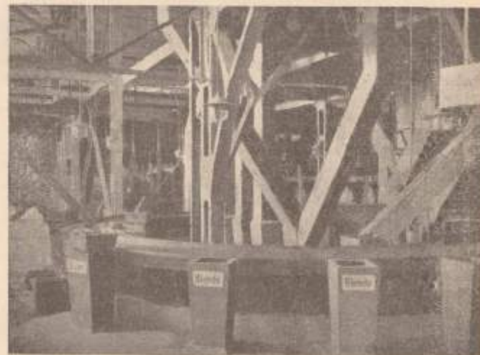
3. kép. Két részre osztott válogatóasztal ülepített darabos ércz számára.
