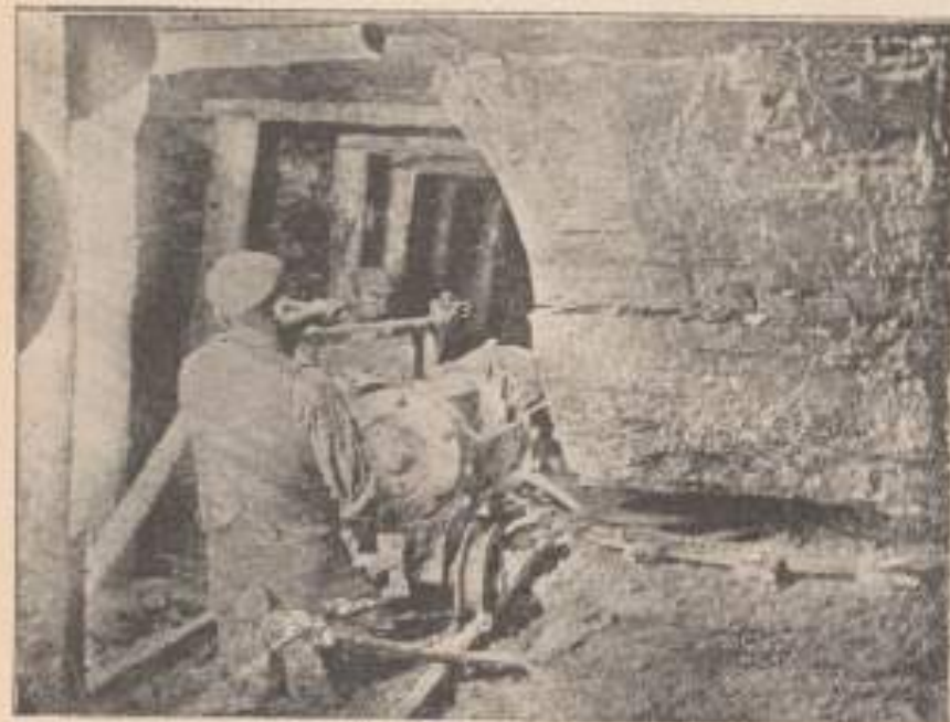
2. ábra. Réselés a szénben (1:1).
