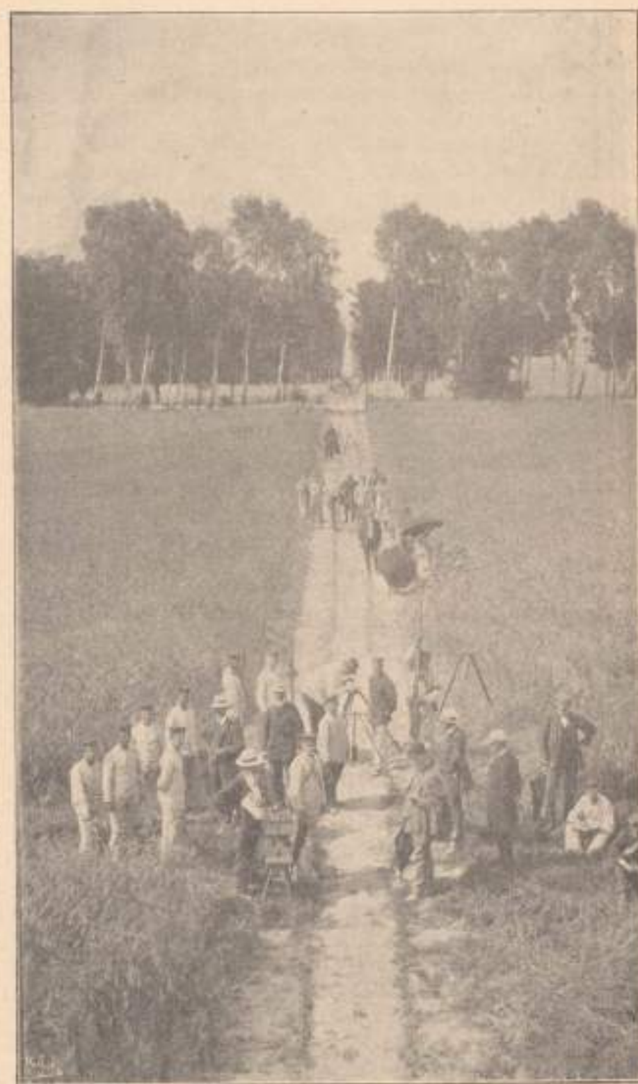
35. ábra. Alapvonalmérés Invardróttal.
