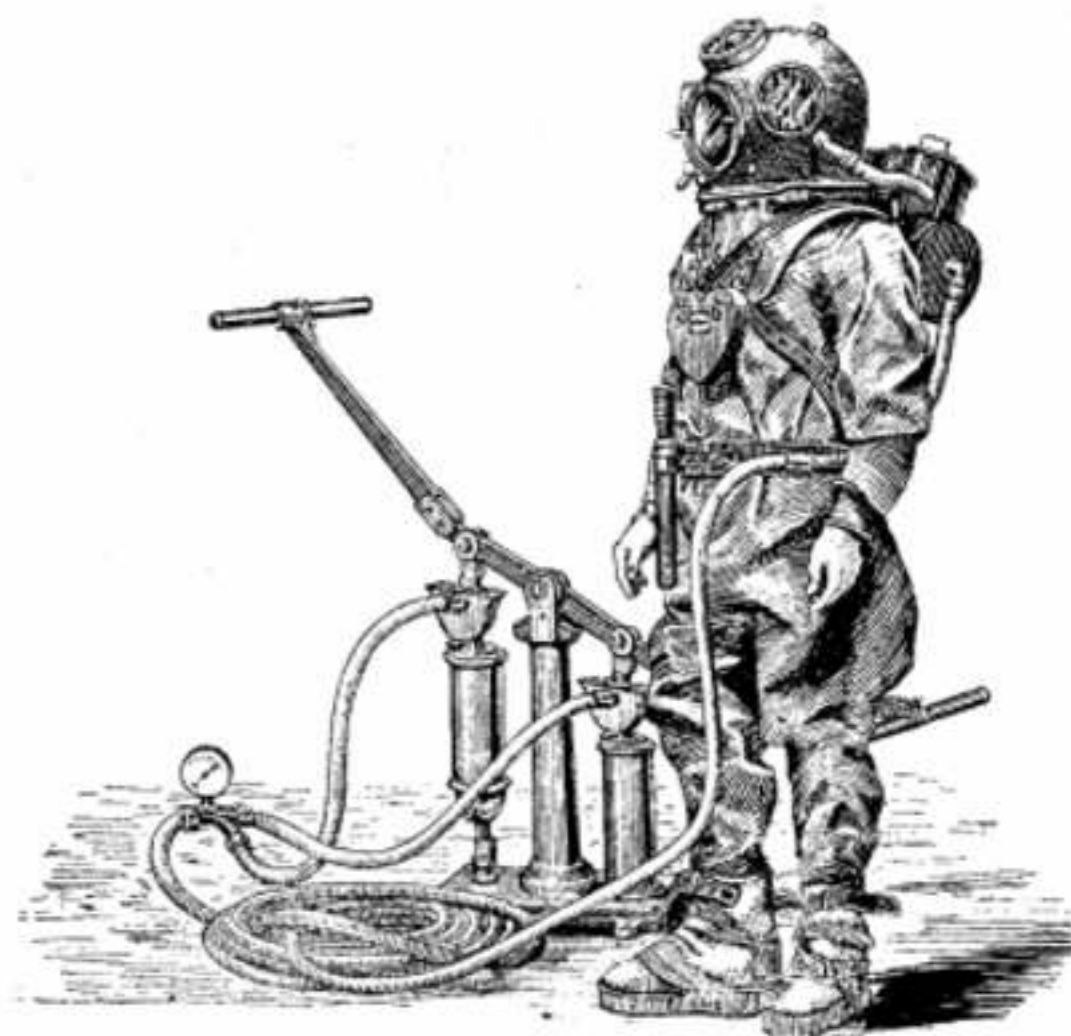
2. ábra. Francia rendszerű búváröltözet légszabályozóval.
