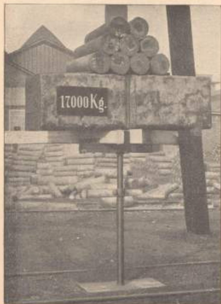
3. ábra. Az oszlop teherpróbája.
