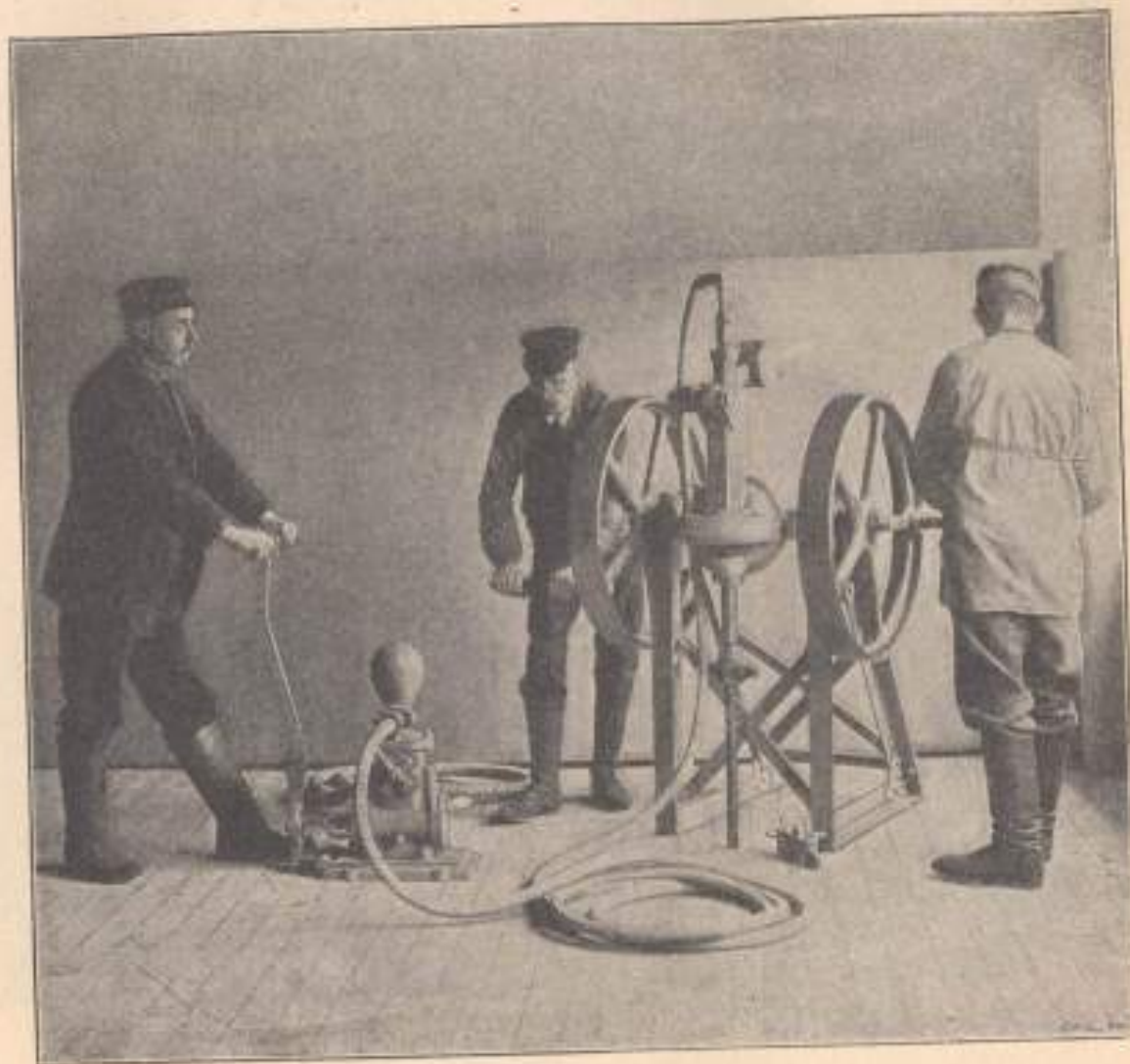
16. ábra. Crälius-féle gyémántfűrógép kézi erővel hajtva.
