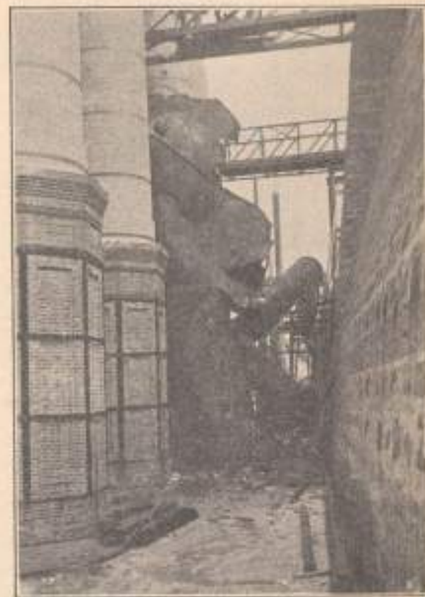
A vajdahunyadi gázmosó a robbanás után.
