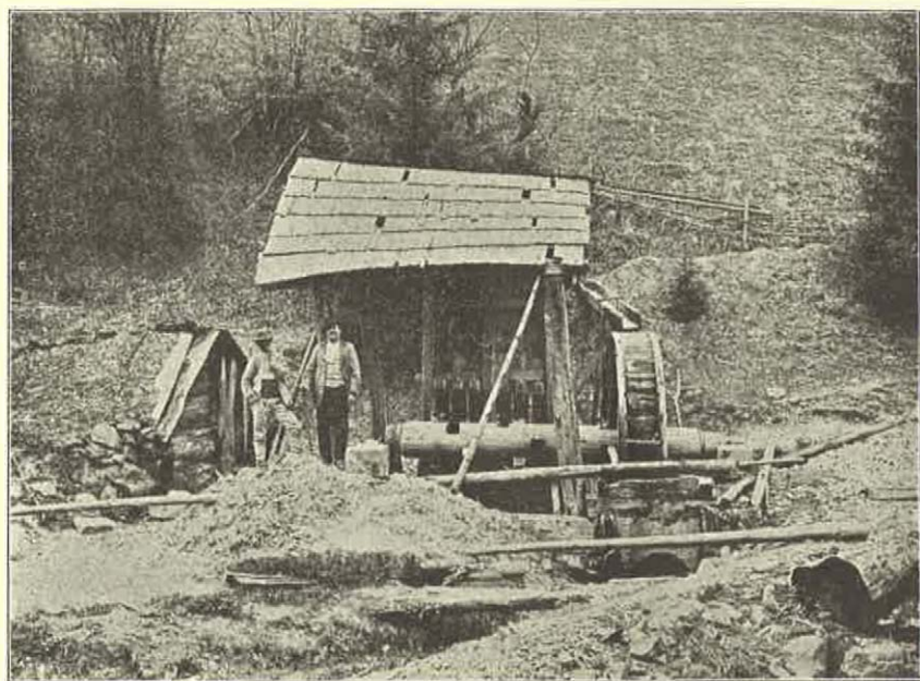
Figur 11. Goldpochwerk mit 6 Pochstempeln des Alex. Turlyák am Izbicsórabach.
