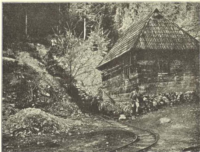
Figur 14. Der Napoleon-Erbstollen der Arámagrube, 854 m Seehöhe.
