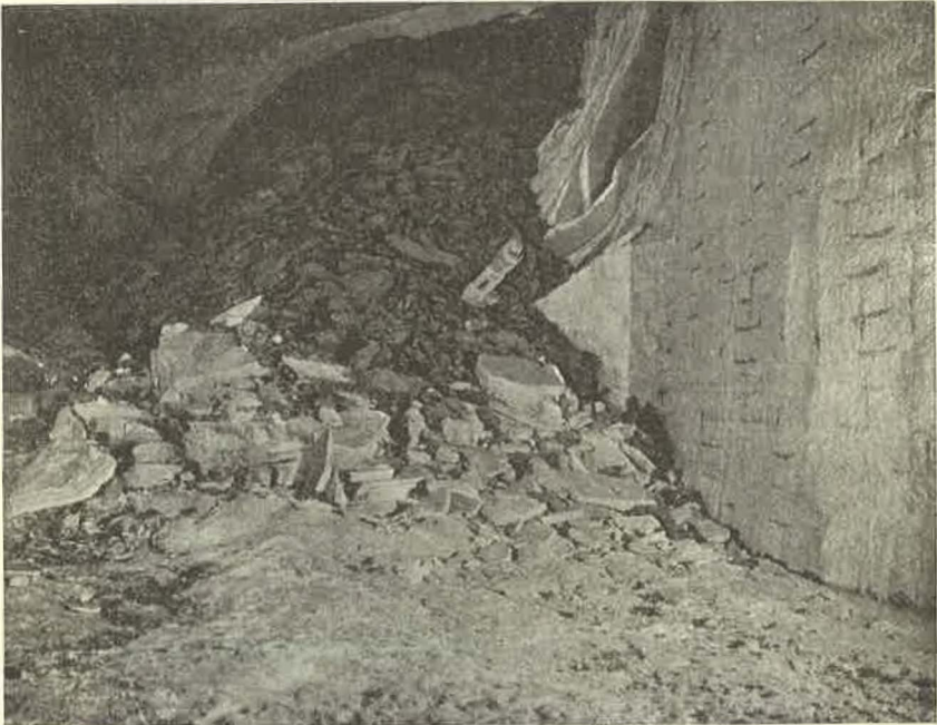
Fig. 5. Eingestürzte Salzwand an der Grenze des Salztones im Rudolf-Schacht. (Originalaufnahme.)
