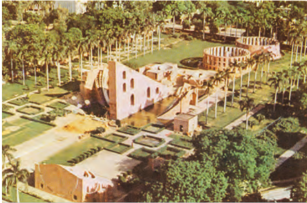
8. ábra. A Jantar-Mantar Obszervatórium Új-Delhiben. A hatalmas építményekkel végezhető csillagászati mérések pontosságára jellemző, hogy a napórával az időt 2 másodperces hibával lehet megállapítani
