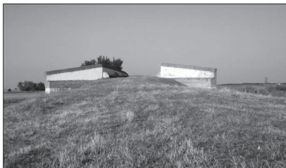
Az 1806-1809 között épült Zádor-híd az egykori S6-út forgalmát segítette
